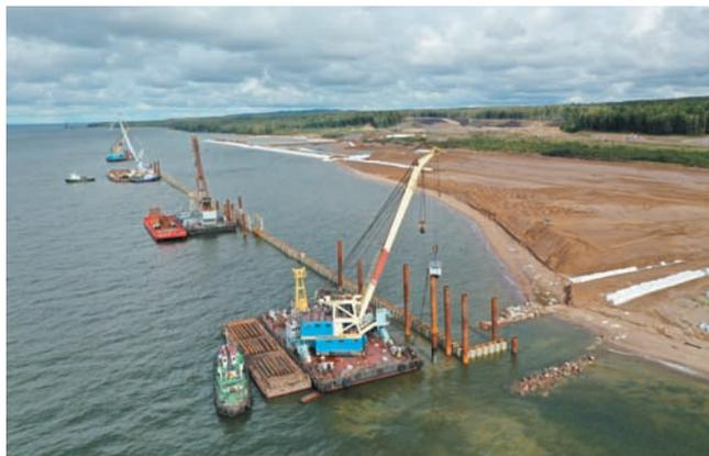
УСТАНОВКА ШПУНТОВОЙ СТЕНКИ ТЕРМИНАЛА LUGAPORT
